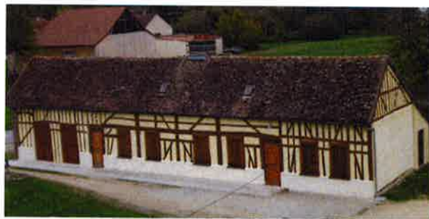
Maison des associations : Rénovation de la façade en pans de bois et réhabilitation d'une salle
