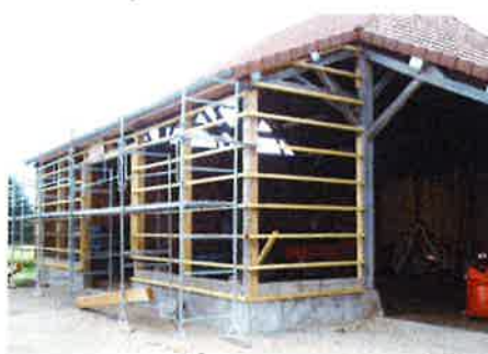
Bâtiment technique : Réhabilitation muret et bardage bois
